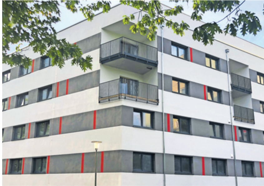
Das Bauprojekt „Zoar – Wohnen am Betzenberg“: Pflegeplätze, Service-Wohnen und Penthouse-Wohnungen zur freien Vermietung. Foto: Zoar
